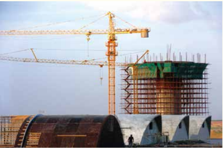
施工中的水塔、蓄水池 Ground & Elevated reservoir
